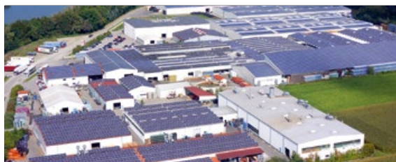
Das bayerische Solarkraftwerk „Maming“, das vom Privaten Institut initiiert wurde, sorgt für eine CO 2 -Einsparung von 610,35 Tonnen pro Jahr.
